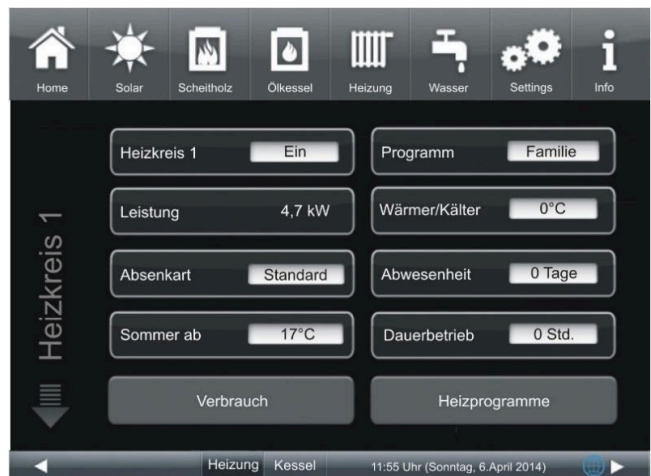
Abbildung 48: Displayansicht am Beispiel für Heizkreis 1
